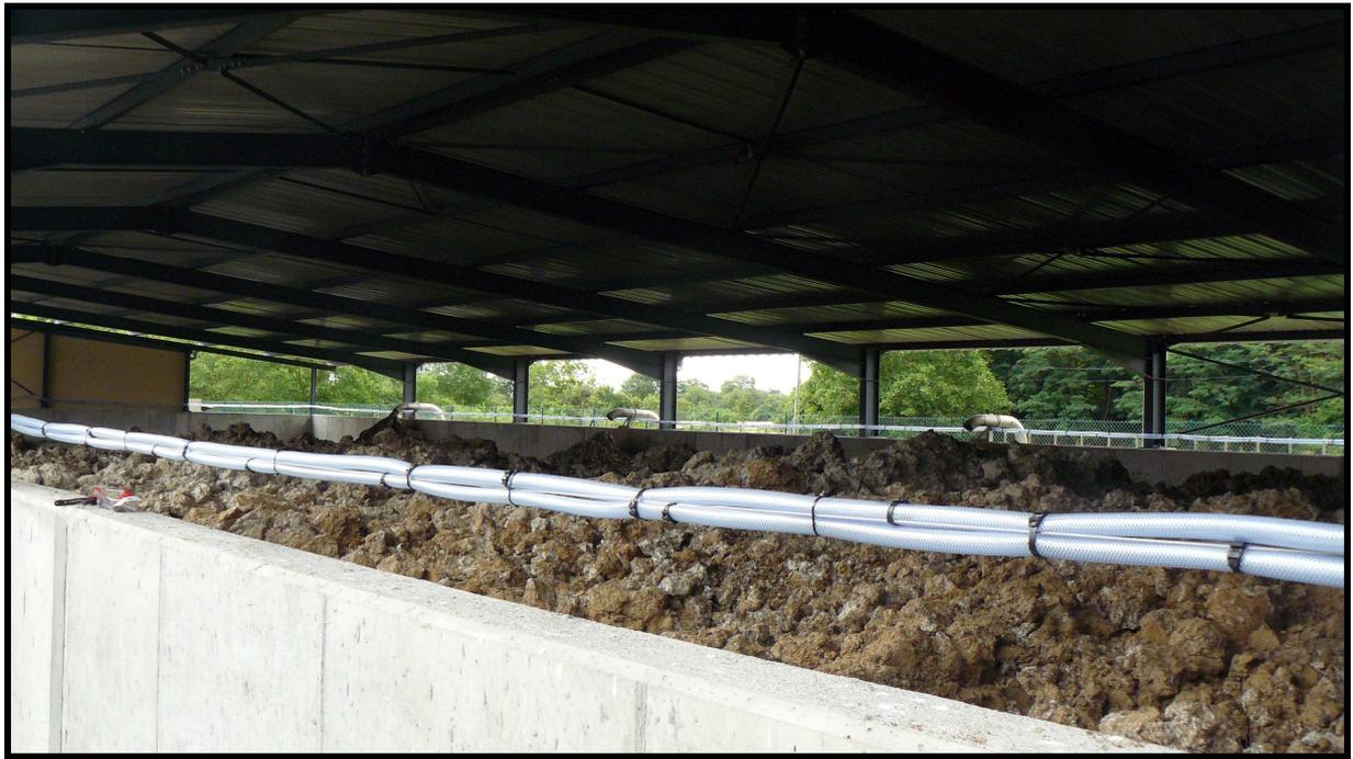
**Detalle de la instalación a nivel de cada conducto a la llegada a los lodos :**
